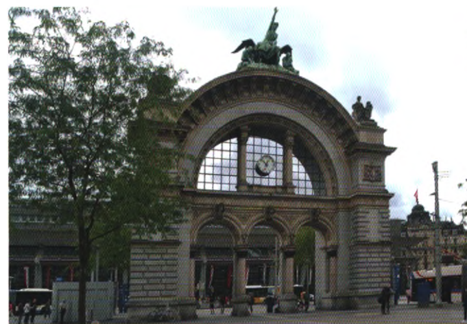
Den oprindelige hovedindgang til banegården i Luzern er bevaret. Bagved skimtes den nybyggede, nuværende Banegård.
