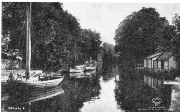
Nättrabyån ved Nättrabyhamn. Til højre dampbådens anløbsplads, yderst til venstre lastekajen, ca. 1930.
