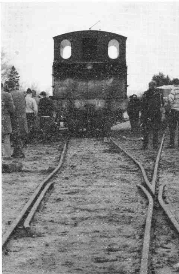
GDS nr. 11 gik på gulvet, da vi forsøgte at benytte »militærsporet« mellem GDS og HHGB på Gilleleje station. (25/3 1962). Foto: P. Thomassen.
