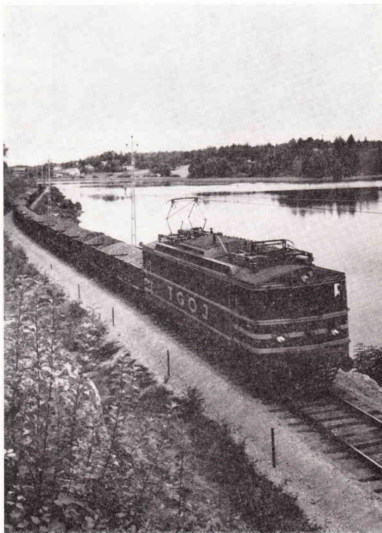
Malmtog på den svenske privatbane Grängesberg-Oxelösunds Järnvägar (TGOJ) fremført af elektrisk lokomotiv litra Ma (4500 hk).
