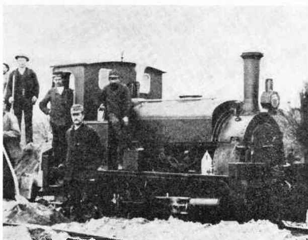
Lokomotivet »Aage« i Grevinge grusgrav under bygningen af Odsherred Jernbane.
