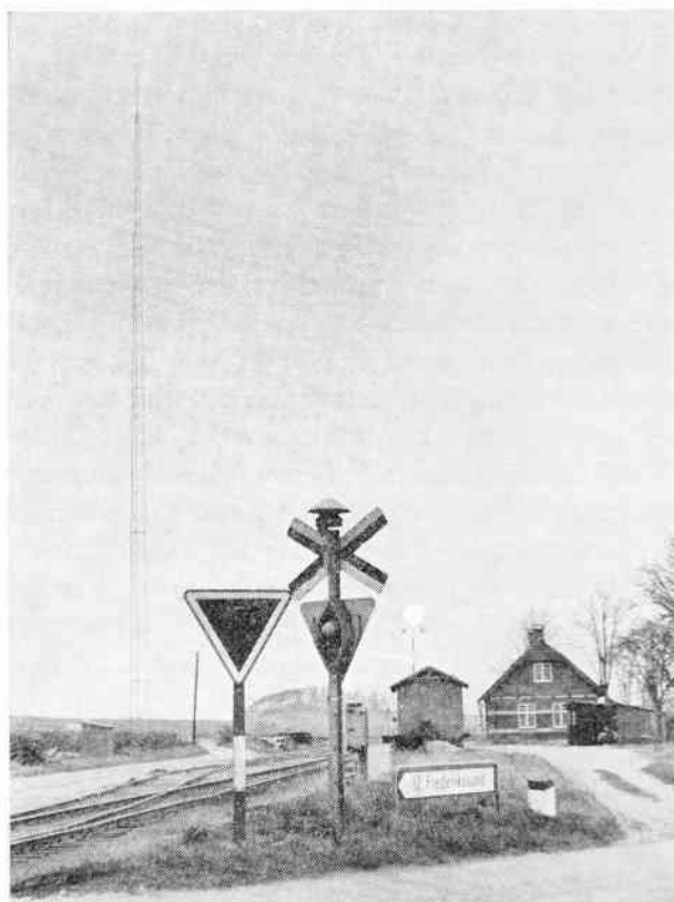
Radiomasten for fjernstyringsanlægget ved Kregme station.
