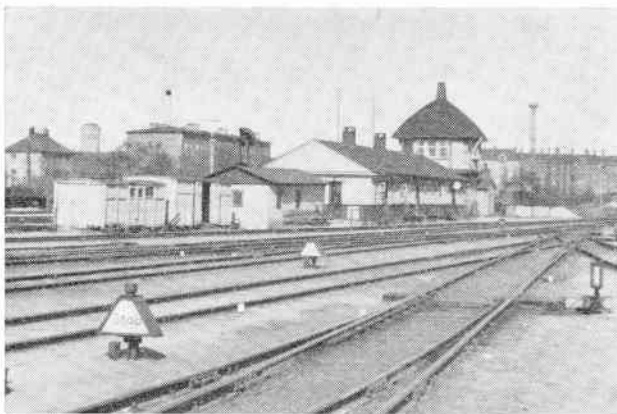
Et par vognkasser, et brændeskur, en træbygning, et »tårn« og togpersonalets »villa« udgør tilsammen »Det gule palæ«. Bemærk »kæmpe-dværgen« midt i billedet.
