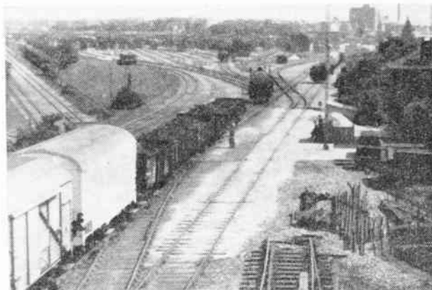
Et træk under rangering ved Post B, som ses yderst til højre. Ved lysmastens fod står rangerlederen ved ranger-radioanlægget, og ved trækket ses hjælperen parat til at afkoble mellem de næste vogne. I daglig tale hedder det om et træk under rangering her, at det er »på broen« – her ses broen, der fører »Nordre«, »Søndre« og »Afgangen« (spor nul) hen over maskinsporene til Hovedbanegården.
