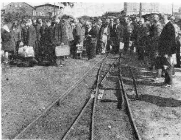
Det ejendommelige sporskifte beregnet for dobbeltflangede hjul (Friedland station).
