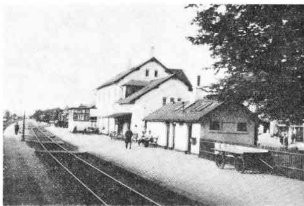
Brønderslev station – med »påklistret kommandopost« (1961). Foto: P. Thomassen
