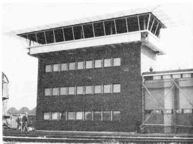
Den nye centralpost på København H – under opførelse.
