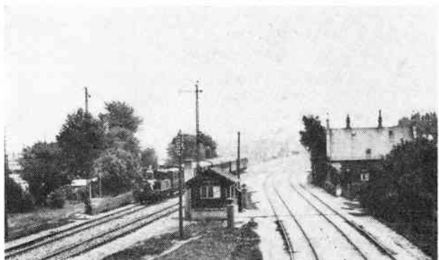
Udsigt fra Svanemøllebroen (ca. 1930). Kolonihaverne i venstre side af billedet er i dag afløst af remiseanlæg og opstillingsbanegård. Foto: P. Rutherford.
