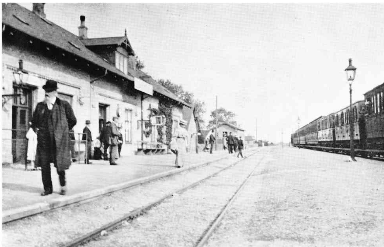
Stemmingsbillede fra Lillerød (nuværende Allerød) station – taget en sommerdag i 1905. Nu 60 år senere er idyllen borte, den gamle lygte er erstattet af en køreledningsmast – og de rolige, afbalancerede mennesker på perronen er erstattet af travle, rastløse ditto.
