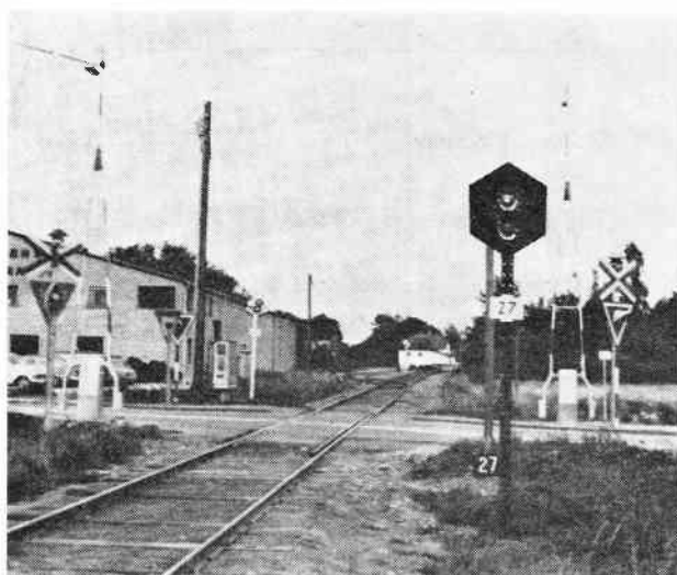
Overkørsel nr. 27. Automatisk halvbomanlæg for Adellers Alle ved Faarevejle station – med overkørselssignal.
