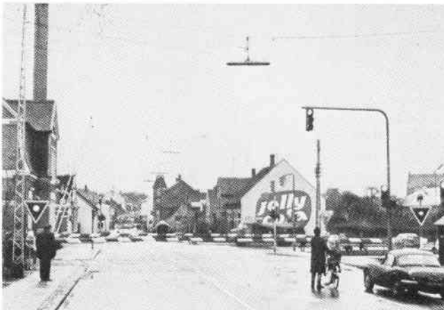
Overkørselsanlægget (med gadesignaler) for Svingelsvej i Nakskov (overkørsel nr. 34 a).
