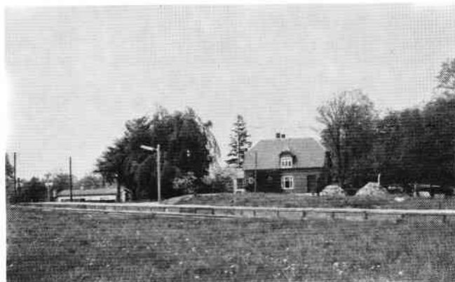
Det nye Pibemose trinbræt (under anlæg).
