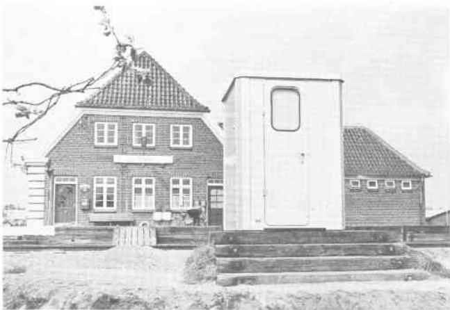
Fig. 1. Glasfiberhytten på Tornby station, der indeholder det lokale betjeningspanel, fjernstyringsstativet m.v.
