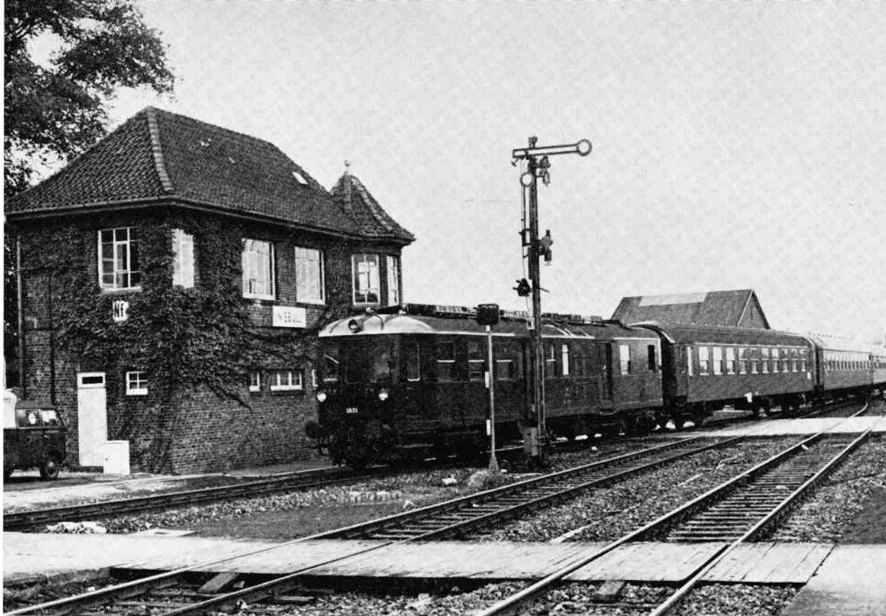
Mo 1821 med eksprestog 2124 under indkørsel til Niebüll i Tyskland den 14. august 1971. Også i tiden 24. juni–27. august 1972 fremfører Mo-vogne tog til Niebüll. Foto: Gunnar W. Christensen.
