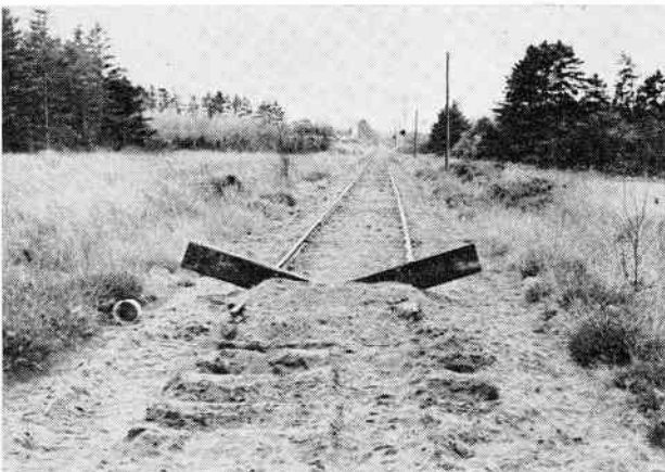
Her ender Varde-Grindsted Jernbane efter at sporoptagningen er afsluttet; billedet er taget den 22. oktober 1972.
