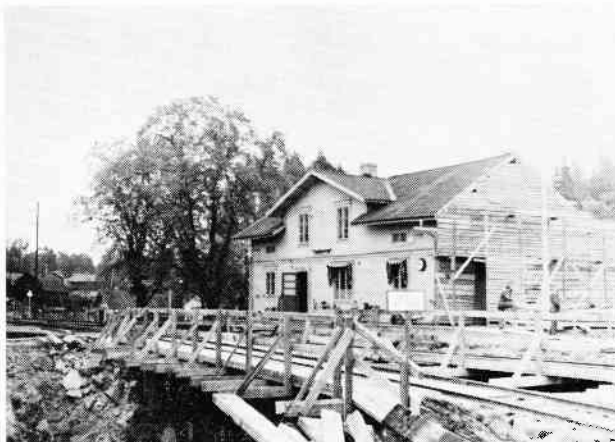
Långshyttan station (med underføring for vej under anlæg) (1955). Foto: Birger Wilcke
