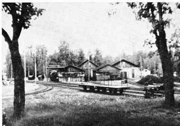
BLJ's remise og værksteder i Stjärnsund (1955).
