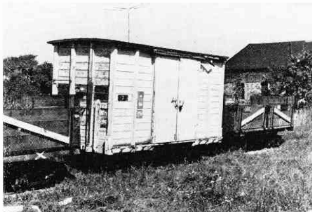
Roebanewogne nr. 7 og 3602 efter at der var slået græs omkring dem, således at en restaurering kunne begyndes den 26. august 1973.
