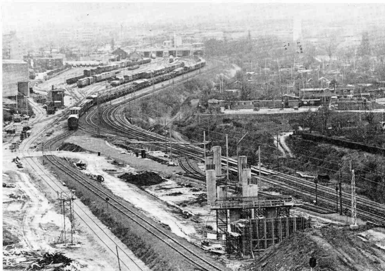
Overføringen af den kommende Hareskovbane over Ydre Bybane i østenden af Lersøen station er ved at tage form. Godstoget midt i billedet er netop ankommet fra Østerport ad Frihavnsbanen. (Brobyggeriet medfører en række midlertidige sporforlægninger, der vil blive nærmere omtalt i et kommende nummer af »Jernbanen«). (Optagelsestidspunkt: Medio november 1973).
