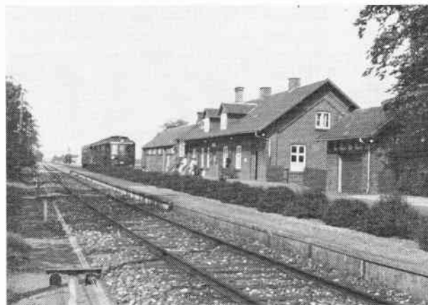
Stationsbygningen i Kibæk er nu nedrevet, men i juni var endnu alt idyl omkring stationsbygningen. Foto: Jens Larsen.
