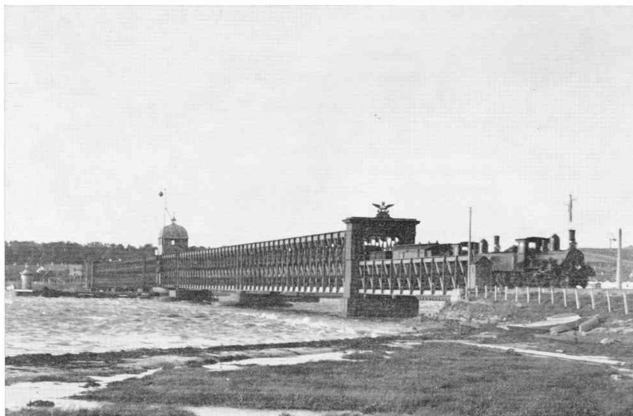
Limfjordsbroen mellem Aalborg og Nørresundby, 1927.
