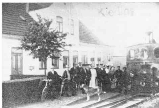
Kiding station genopført efter branden, 1912.
