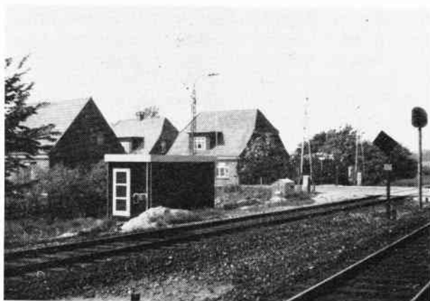
Relæhytte i Aulum. Antennen, som skimtes ved hyttens højre hjørne, benyttes til strækingsradioanlægget.
