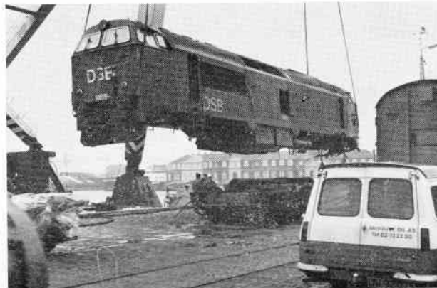
Bogieudskiftning på MZ 1455, da lokomotivet den 25. november 1979 atter vendte tilbage til landjorden efter et par dages ophold i Korsør havn. Foto: Erik Buus.
