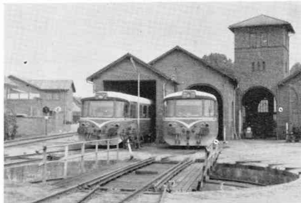
En del af HHJ's remiseanlæg i Odder med den interessante drejeskive, der har to spor, sommeren 1977. Foto: Johannes D. Hansen.
