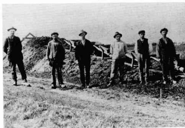
Anlæg af snevolde ved Nørre Felding på Ørnhøj-Holstebro banen i 1925.
