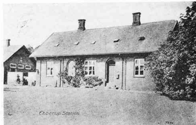
EBBERUP fra vejsiden ca. 1908. På Assensbanen havde næsten alle mellemstationer 5 fag vinduer til vejsiden med vekslende flad- og rundbuer. Bygningen har saddeltag og eneste udsmykning er liséner. Typen genfindes på mange samtidige baner, f.eks. den vestjyske længdebane og himmerlandsbanerne. På thybanen var enkelte blot på to fag vinduer, f.eks. Lyngs, og mange måtte udvides i tidens løb. Ebberup har overlevet som postekspedition og ligner sig selv udover at der er monteret thermoruder o.lign.
