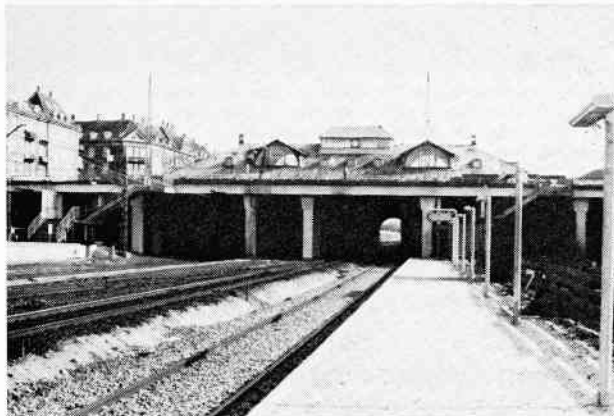
Udsigten mod nord fra banegraven syd for stationen. Til venstre ligger S-togsperronen med spor 13, og fotografen har stået på den sydlige del af den nye perron for spor 0. Endnu er »huset« for kommandoposten fra 1917 på bygningens tag ikke fjernet. 1983.
