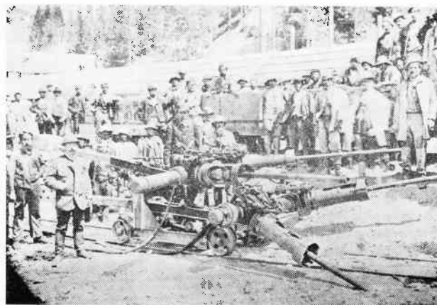
En af de mekaniske boremaskiner, der blev anvendt ved bygningen af Arlberg-tunnelen. Foto: Arkiv Østrigs Turistbureau
