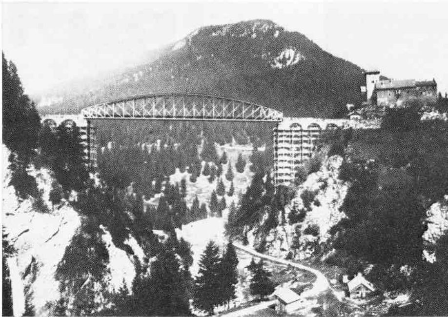
Den 231,6 m lange Trisanna bro er Arlbergbanens kendteste bygningsværk bortset fra selve tunnelen. Optagelsen viser broens oprindelige udseende omkring 1920, senere fik broen forstærkningsbuer under brodækket, og i 1964 udskiftedes den gamle bro med en ny, som anbragtes på de oprindelige brofæster. Foto: ÖBB. Gengivet efter F. Marti & A. Schneider: Die Arlbergbahn.
