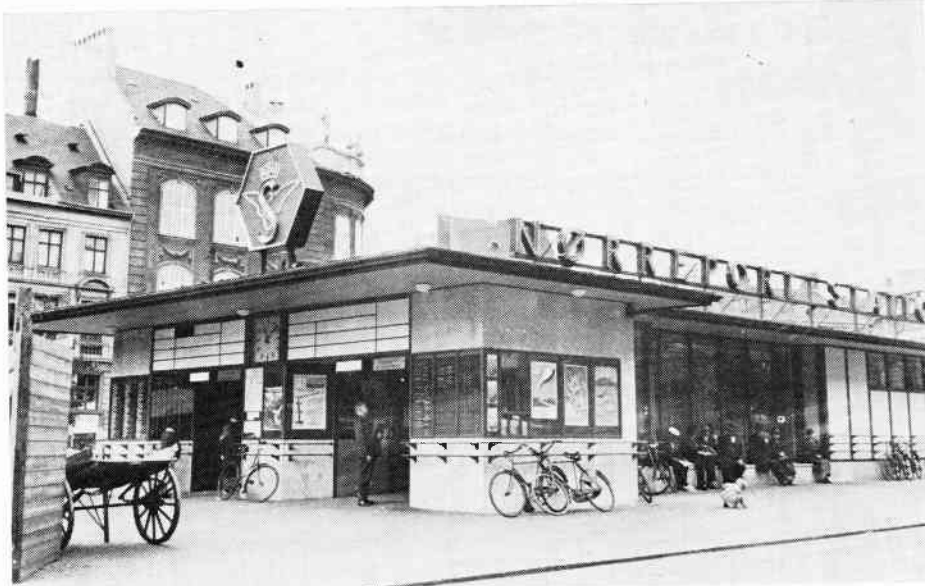
I forbindelse med elektrificeringen af strækningen København H-Hellerup blev der opført en ny ekspeditionsbygning på Nørreport station. Bemærk tavlerne ved siden af uret, som var beregnet til at vise togafgangstiderne, samt DSBs kende-mærke for den københavnske nær- trafik 1933.
