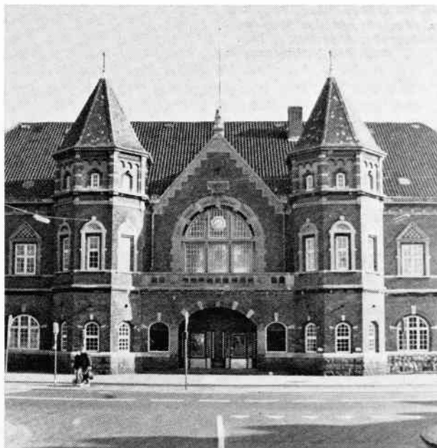
Indgangspartiet med de to tårne, som det ser ud i dag. Den oprindelige åbne loggia blev delvis muret til i 1944, 1983. Foto: Bygningstjenesten
