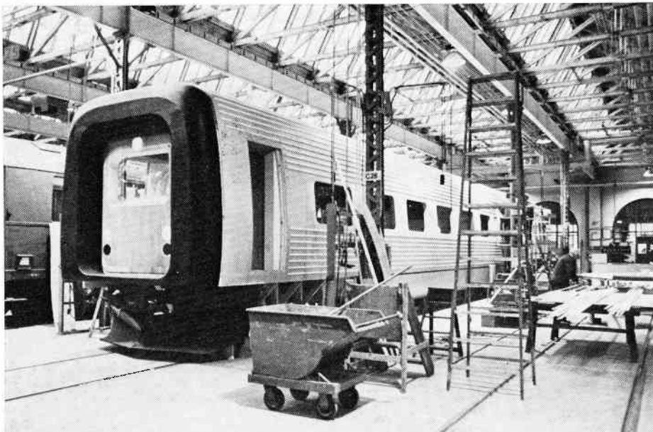
På Centralværkstedet København er man ved at lægge sidste hånd på den såkaldte »mock-up« af en IC/3 vogn. Selv om vognen er udført af enkle materialer som træpinde, krydsfinér og lister vil den efter opmalingen i de rette farver illudere fuldkommen som en færdig, køreklar vogn. Med denne arbejds-metode opnår man dels at kunne vurdere og afprøve formgivnings-mæssige ideer og praktiske mulig-heder og dels at rette eventuelle fejl, forinden togsættene bliver sat i produktion. Den 20. december 1984. Foto: Anders Løvenkjær/Mafd AKV
