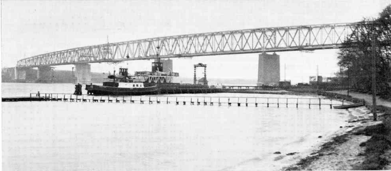
Den næsten fuldførte bro er fotograferet i december 1934 som baggrund for bilfærgelejet i Snoghøj, hvor færgerne »Inger« og »Nanna« ligger fortojet. Foto: Stender/Det kongelige Bibliotek.
