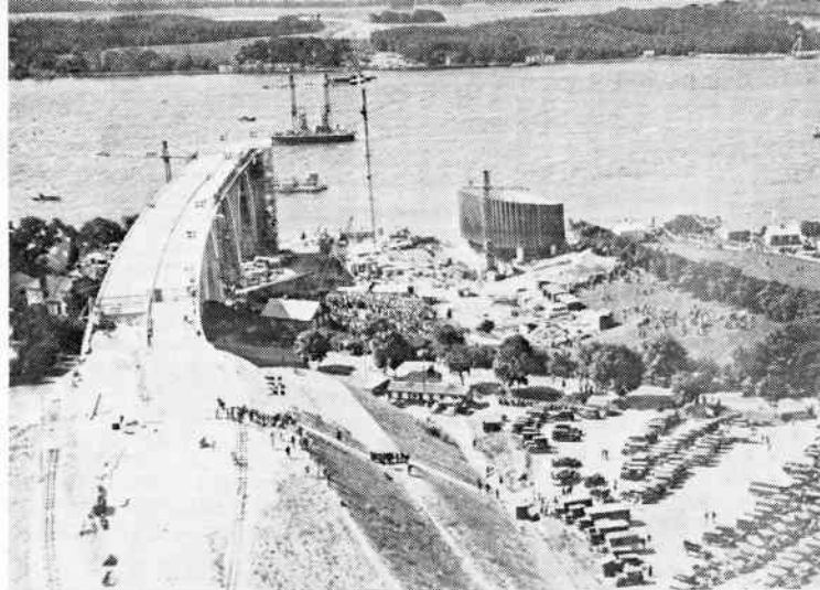
Stabelaflojningen af den sidste sænkekasse (nr. 2) fra byggepladsen på Snoghøjsiden af Lillebælt skal netop finde sted under påsyn af Kongen og Dronningen foruden et stort antal mere anonyme danskere den 19. juli 1932. Bemærk hvorledes sænkekassens bund, der på beddingen vender opad, er udformet, så den nøje følger havbunden, når den bliver placeret på den endelige plads. Foto: Dybdal/DSB Jernbanemuseum
