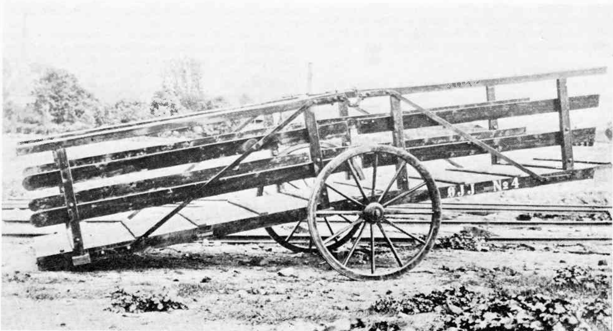
Flytbar kvægrampe af samme type som Scandia leverede til VLJ i 1879. Dette eksemplar leveredes til Østjydske Jernbane i 1876. Rampen havde et bevægeligt led ved hjulakslen, så mindre højdeforskelle kunne udjævnes. Foto: Arkiv JMJK
