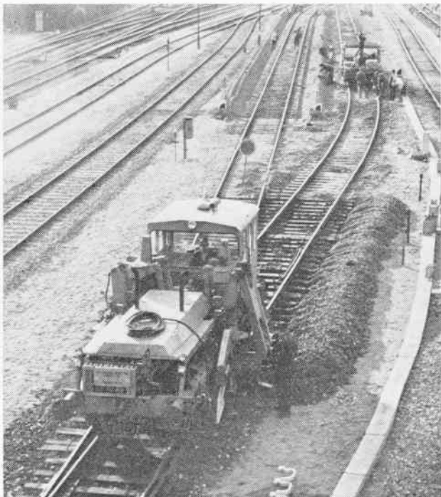
Ballastudgravningsmaskine Bum 1 arbejder i et sporskifte i Korsør den 13. november 1981. Foto: Jan Lundstrøm
