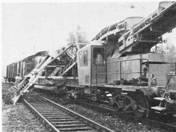
Ballastrensemaskine af type RM74UHR ses i arbejde i et sporskifte. Til venstre ses den arm, hvori løber den særlige kæde, der »trækker« ballasten bort under sporet, og til højre ses transportbåndene, der fjerner affaldet fra rensningen enten til vogne eller til arealer ved siden af sporet. Foto: Plasser & Theurer
