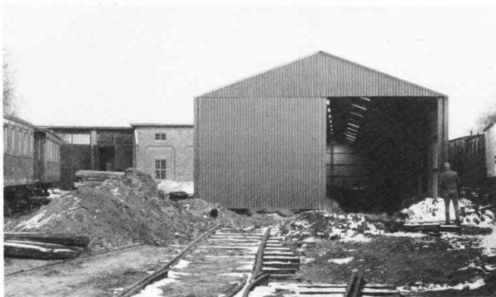
Medens tankerne om en vognhal går over to decennier tilbage, stod selve byggeriet i skarp kontrast hertil. På et par måneder var den bare jord omdannet til en smuk vognhal. På Flemming Jakielskis billede fra 27. februar 1988 mangler dog en del sporarbejde og almindelig oprydning efter det grove arbejde. Tre måneder efter var vognhallen indviet.
