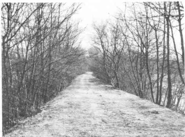
Velbevaret strækning set fra Even Bro mod syd. Foto 12. april 1986: Per Andersson
