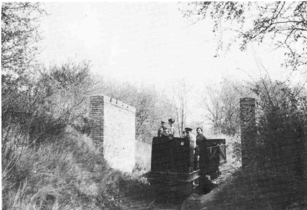
At der mangler en bro er vist tydeligt, men pillerne er der da. Bloustrødbanens RVT nr. 1 passerer her »viadukten« på vej mod Tivoli Huse (sporet ender dog endnu brat ved S-banens overføring). Foto i april 1990 af Oscar Meyer.
