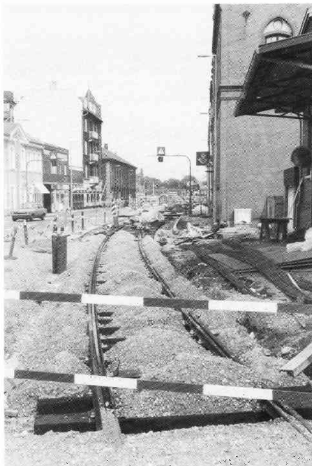
Hornbækbanens nye forbindelsesspor til Helsingør station kort inden færdiggørelsen. Foto den 13. maj 1990 af Bent Jacobsen.
