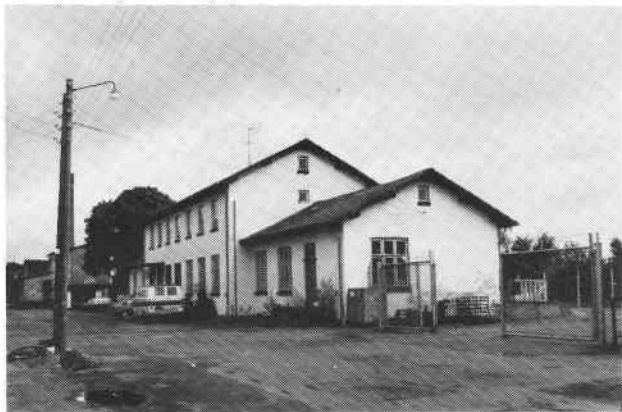
Den gamle stationsbygning i Middelfart blev efter sin afløsning i 1935 ikke nedrevet, og den har fundet ny anvendelse uden for DSBs regi. Der er imidlertid forskelligt i bygningens udformning, hvorved oprindelsen som jernbanebygning røbes (det samme er ejendommeligt nok tilfældet med langt de fleste jernbanebygninger, der er endt som noget andet), og bladets redaktør har faktisk haft den tanke at bruge dette billede i rubrikken »Sporhunden«! Foto: Per Andersson.
