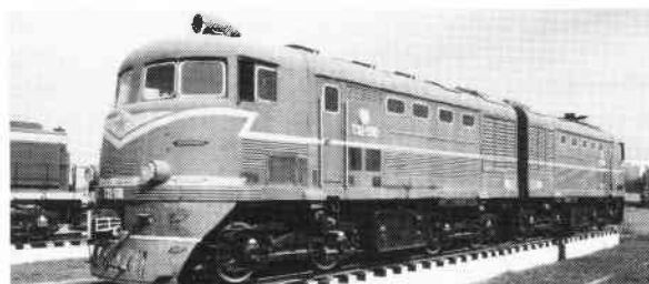
Gråmalet diesellok TE2 508 leveret til åbningen af den sydlige hovedlinje i 1955. TE2 er det første, sovjetiske strækingsdiesellok baseret på dobbeltlok-konstruktionen. Typen har elektrisk kraftoverføring og seriebyggedes fra 1948. Med 2x1000 hk er typen ikke egnet til større tog, men ses stadig i drift såvel i Sovjet som hos MTZ.
