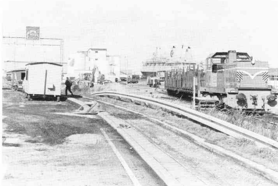
Oplægning af spor og vej i Hirtshals. Hvor vejen brydes op, kommer det nye færgespor til at gå, og hvor HP 16 rangerer, anlægges den nye indfaldsvej til færgenhavnen og byen. Mandag den 23. september 1991. Foto: Ole-Chr. M. Plum, Tølløse.
