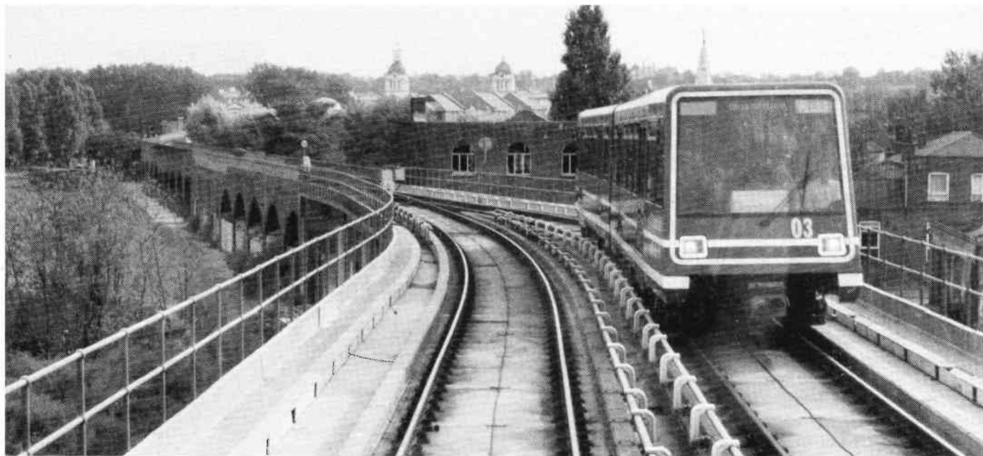
Med kurs mod enkeltsporet på gammel, muret jernbaneviadukt.
