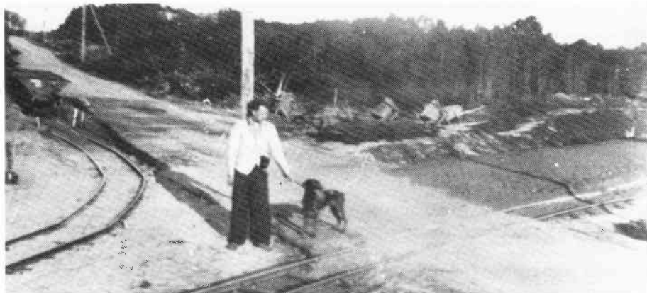
I 1942 optoges dette amatør billede af Nymindegab-banens anlæg. Via tipvognssporet kørtes ballast ud. Denne kom med lastbil østfra og omlæssedes på det lille sidespor langs Gammelgabvej i Lønne. Foto: SAG 14. maj 1942.
