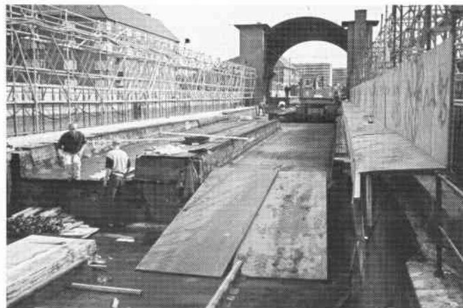
Ingen tog gennem Nørrebro station lige nu! Sådan var beskeden i de tre ugers industriferie - og her er forklaringen i form af betonrenovering ved Nørrebro st. Se iøvrigt om renoveringen i teksten. Foto 10. juli 1993: Bruno H. Pedersen.
