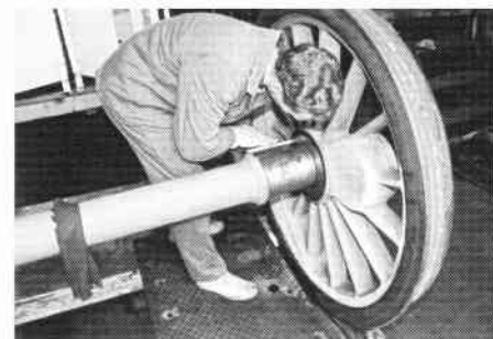
Tilpasning af akselleje...
