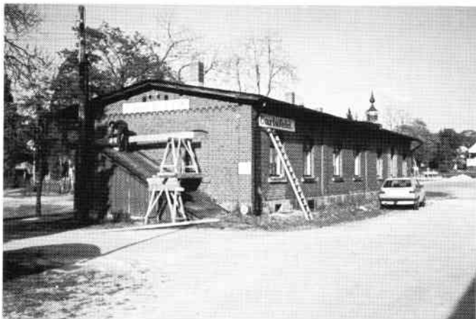
Fra genopbygningen af strækningen Carlsfeld-Stützengrün i 1992: Stationsbygningen i Carlsfeld istandsættes.
