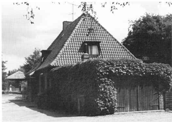
Eskebjerg station, som trods en garagetilbygning ser ganske tilforladelig ud.
