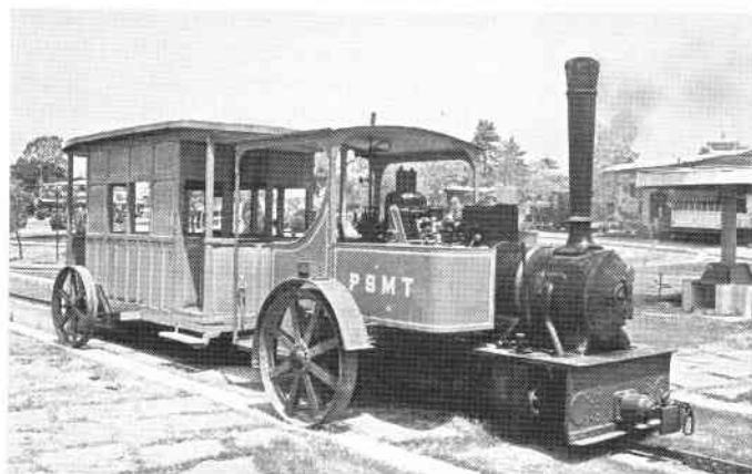
Lokomotiv og vogn fra Patiala State Monorail Trainways. Køretøjerne har dobbeltflangede jernbanehjul der kører på én skinne, og på udliggere til den ene side store støttehjul der løber på vejbanen ved siden af sporet. (Postkort)
