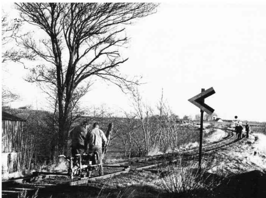
Banearbejde i sving på Løgstørbanen, ved Østrup. Moderniseringen til 22,5 tons akseltryk er afgørende for, om et opland svarende til fem-seks procent af Danmarks areal også i fremtiden skal have adgang til miljøvenlig godstransport. Foto: Mogens Duus, 17. februar 1989.
