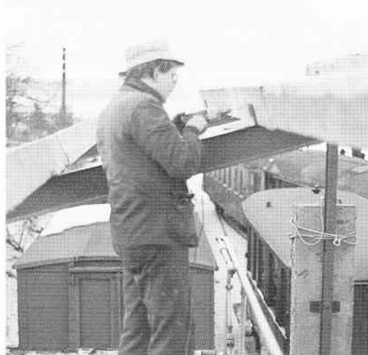
Tagåse lægges op fra tårnvognens øverste dæk.
