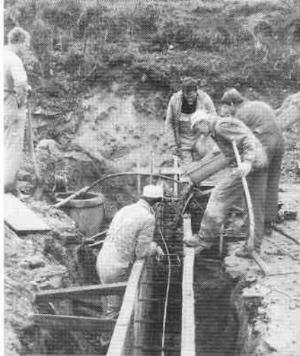
Fundamentet støbes. Efteråret 1981.
