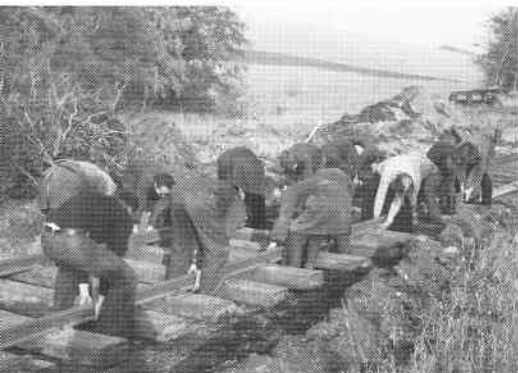
▼ 34 m spor lagt i Handest på én dag - med »klør fem«!
