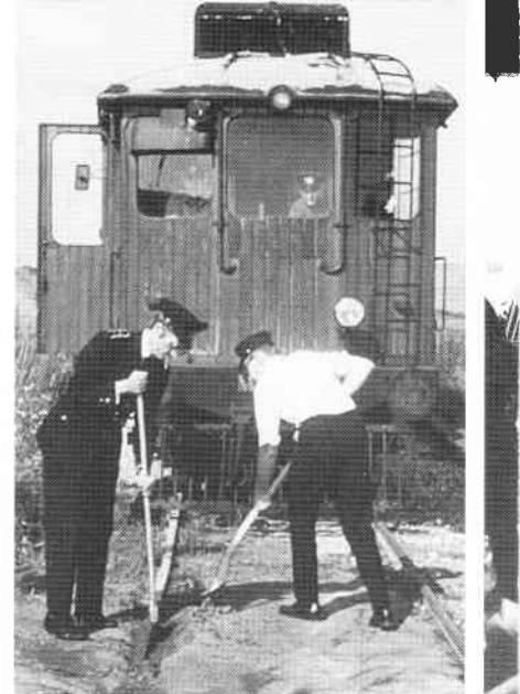
Kraftige regnskyl gi'r skidt i overkorslerne ved de mange markveje. Og så må der renses. Foto 1/8 71: Hans Jørn Fredberg.
