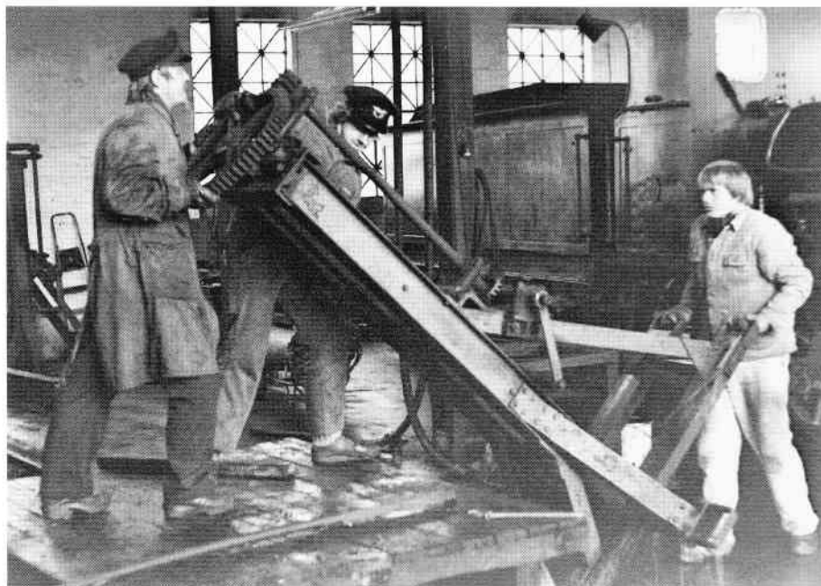
En løftebuk til at løfte nr. 19's undervogn hentes ind i remisen på en trolje. Som man nok bemærker sker det med håndkraft! Vinter 1980/81. Foto: SC.
