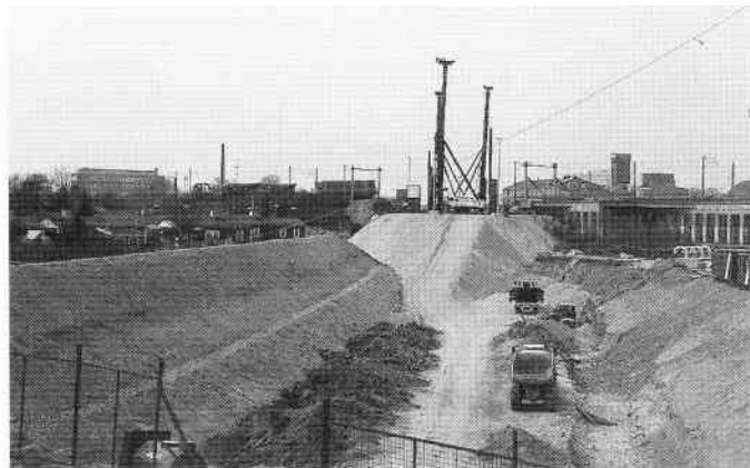
Her skal Øresunds-godsbanen flette ud, ved Sjøløv. Til venstre stedet set 4. marts 1996, til højre syv uger senere, 20. april, da S-banen var spærret for nedramning af fundamenter til godsbanens underføring (Wilhelm Frendrup).
