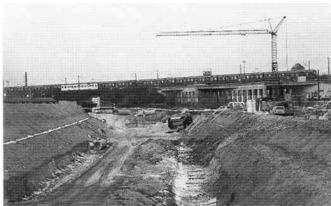
Her skal Øresunds-godsbanen flette ud, ved Sjøløv. Til venstre stedet set 4. marts 1996, til højre syv uger senere, 20. april, da S-banen var spærret for nedramning af fundamenter til godsbanens underføring (Wilhelm Frendrup).
