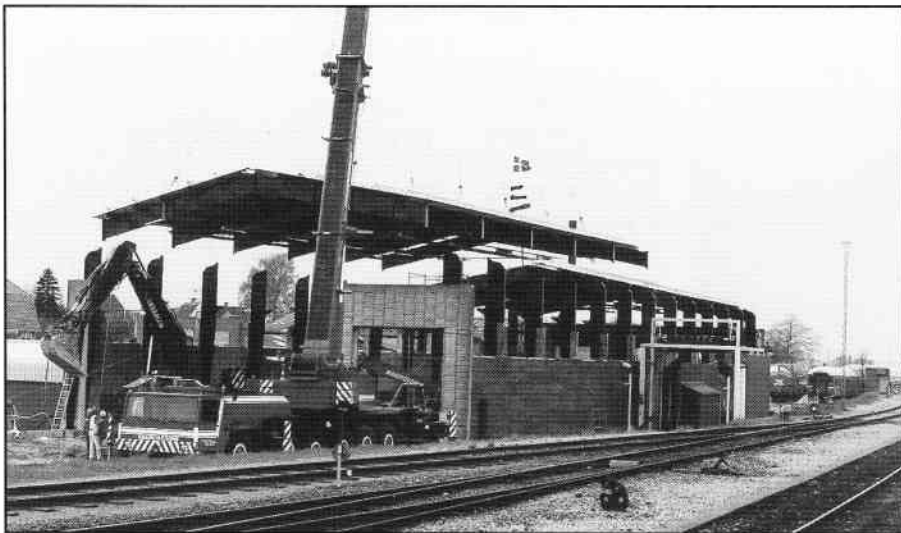
Livlig byggeaktivitet præger Holbæk station, hvorefter alt gøres klar til modtagelse af IC/2-togene på OHJ/HTJ. Læs mere i teksten. Her løftes taget på det gamle værksted, så de nye tog kan løftes inde. (Ole-Chr. Munk Plum)
