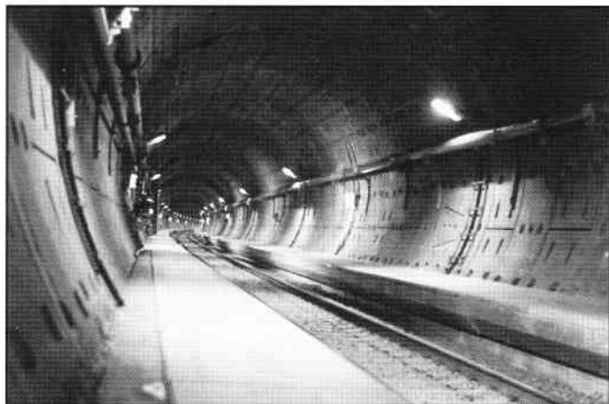
På bunden af Storebælt, østtunnelen omtrent ved det dybeste sted, så der således ud ved DJKs udflugt 7. september 1996. Sammenlign med tegning foregående side! (Wilhelm Frentrup).
