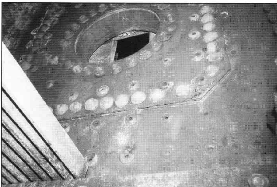
Lappen og fyrhulsringen monteret med nagler, støttebolte og sprængskruer. Lidt af den nyfremstillede rist ses også. Billedet er taget i efteråret 1995, da LJ 19 havde været prøveopfyret.
