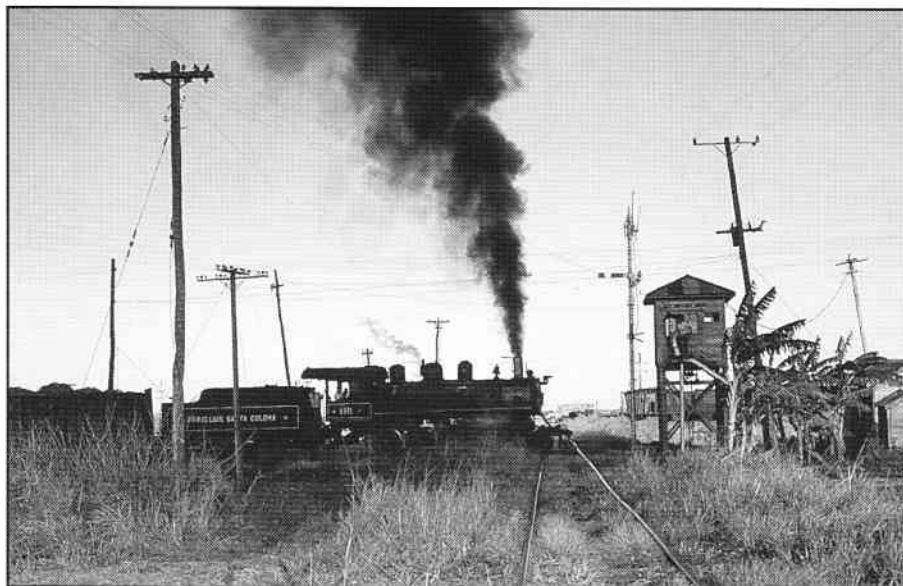
Adskillige steder på sukkerbanerne findes løjerlige udfletninger og niveauekrydsninger, sidstnævnte i visse tilfælde sågar mellem forskellige sporvidder. Her er lokomotiv 1711 - bygget af ALCO 1920 - på vej over niveauekrydsningen ved Roble mellem 211 og 212.
