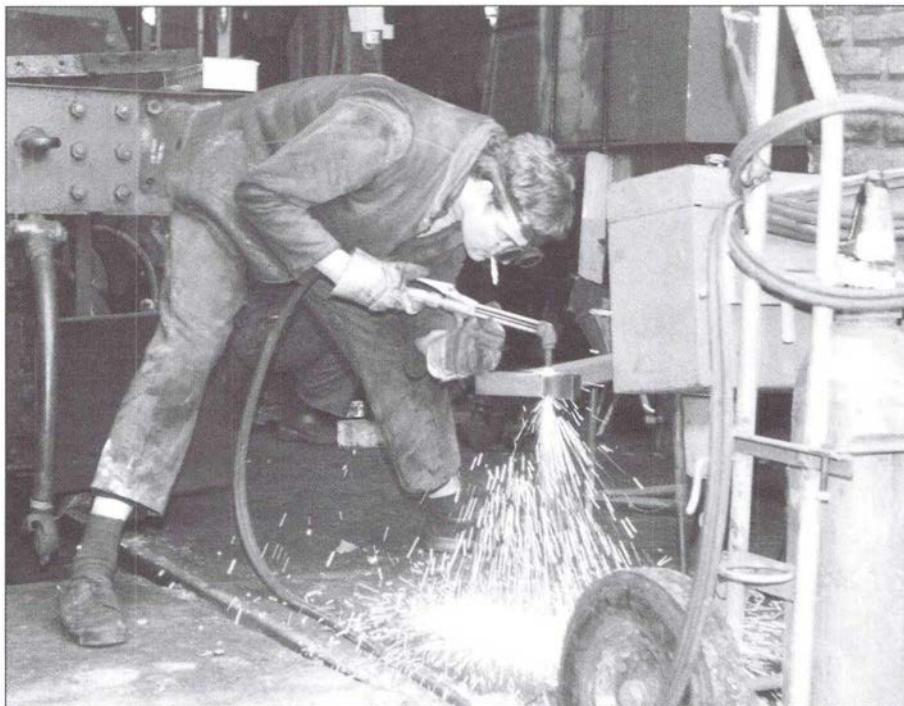
Hvem har »patentløsningen« på de tekniske udfordringer - smeden eller maskinarbejderen? De har i hvert fald hvert sit forslag. Her er det smeden (Anders Bruun), der er i fuld sving med at afkorte tværafstivningen til sidekedelstyret.
