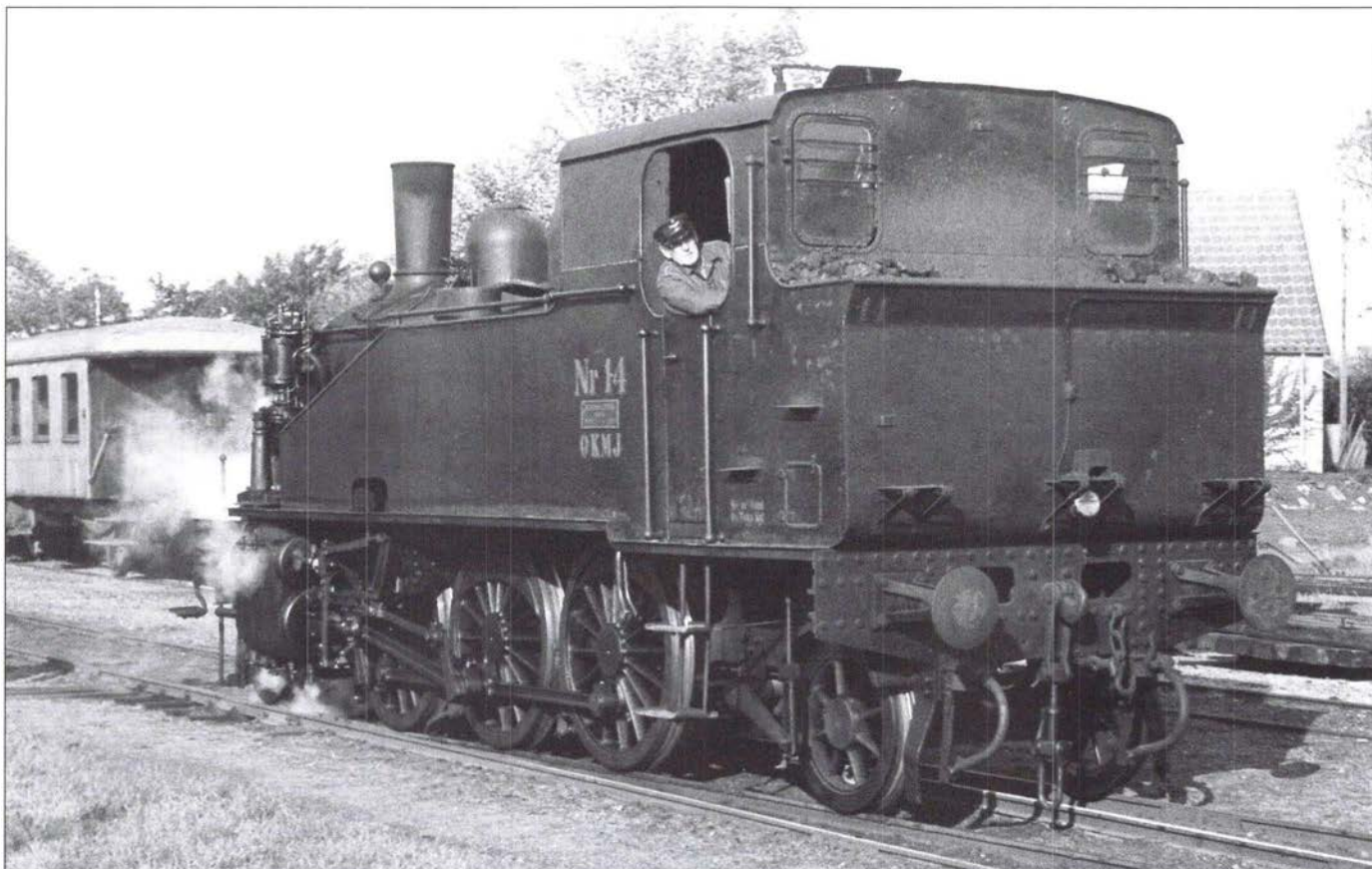
OKMJ 14 i Martofte oktober 1964. Bemærk vandpåfyldningsstudsden øverst på vandtanken og dennes skarpe knæk. De manglende fodtrin på vandkassen fremgår ikke af dette billede. (Lars Viinholt-Nielsen)
