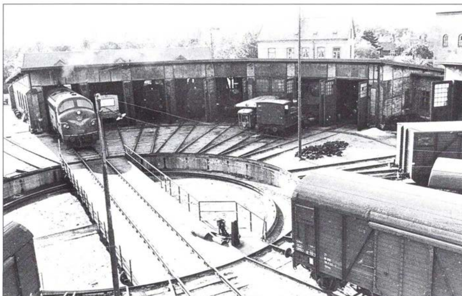
Vestre remise, nu hjemsted for DSB Museumstog. Remisen er ligesom hovedbygningen fredet. Foto: Simon Boertmann.
