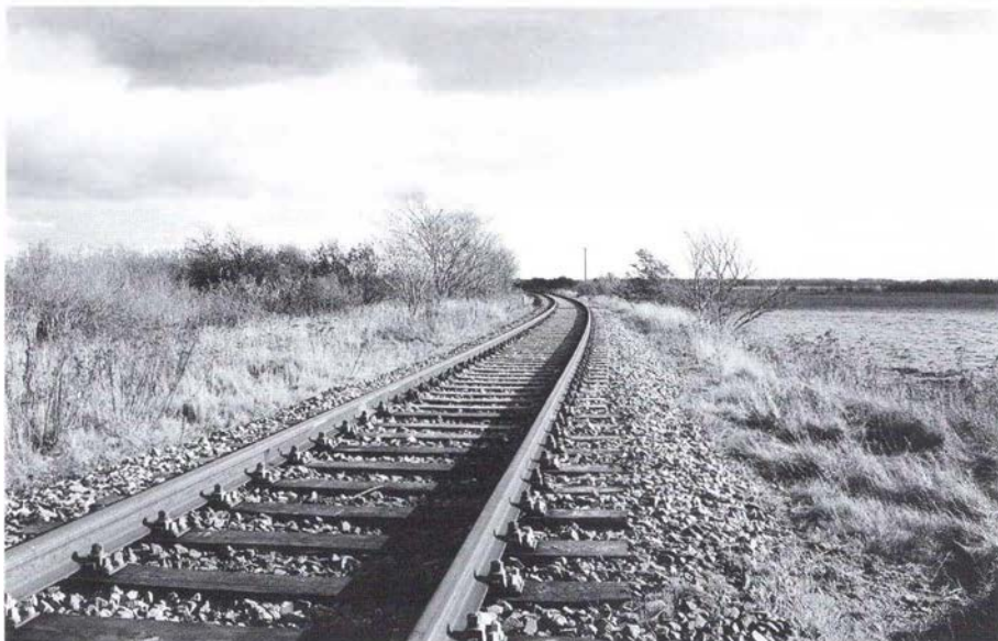
I tillid til det forventede trafikpotentiale har DB på den tyske side renoveret strækningen Tønder-Niebuß med nye skinner på betonsveller. Foto: Robin Roost.
