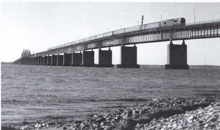
Her ses MZ 1455 med et af B-vognstogene til Padborg under passage af Storstrømsbroen den 19. marts 1998. Foto: Lasse T. Petersen.
