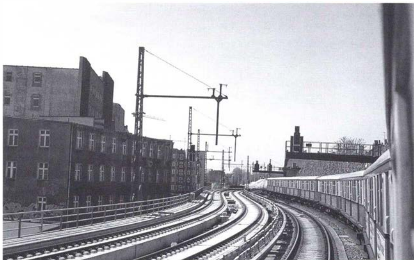
Renoveringen af Stadtbahn er nu tilendebragt, og de sidste detaljer finjusteres. Den nye anlægsform med benyttelsen af "Slaptrack" ses tydeligt. Foto: René St. Olsen
